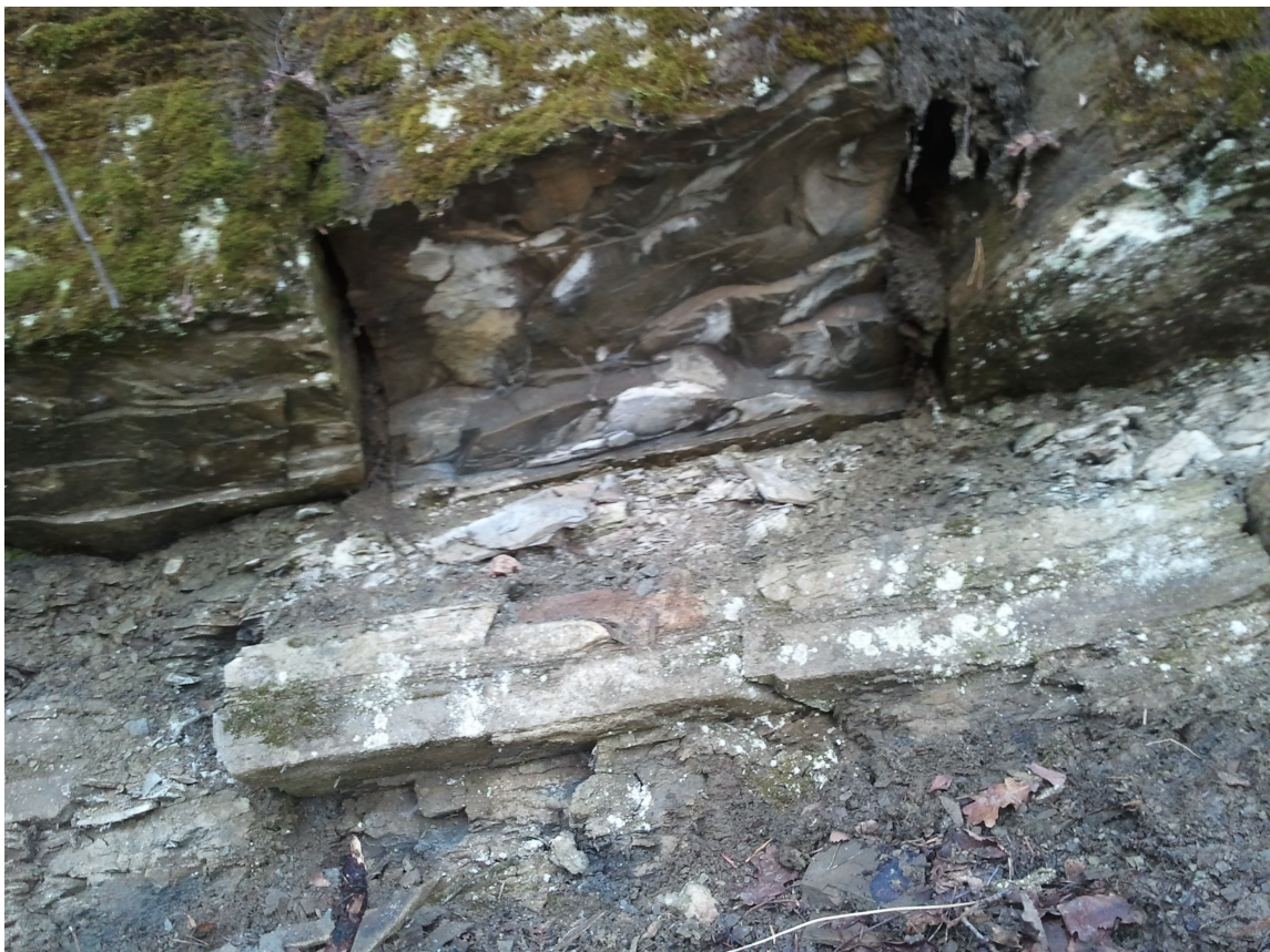
Fot. 4 Odsłonięcie naturalne piaskowca na zboczu góry (szczyt niszy osuwiskowej)
