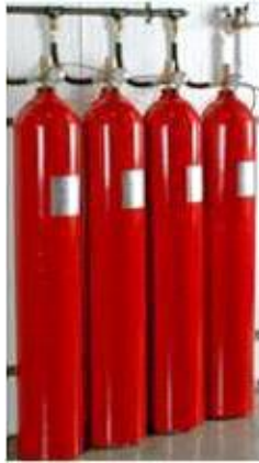
Rysunek 70. Zestaw butli z gazem gaśniczym – źródło: Internet
