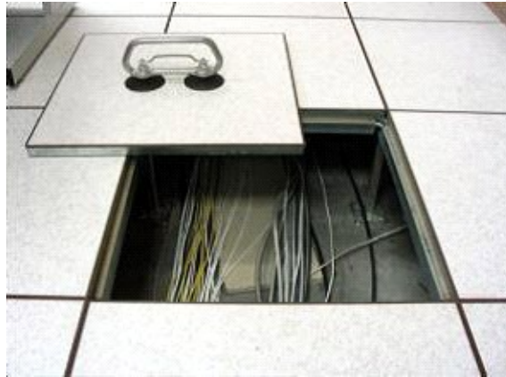
Rysunek 59. Podłoga techniczna
