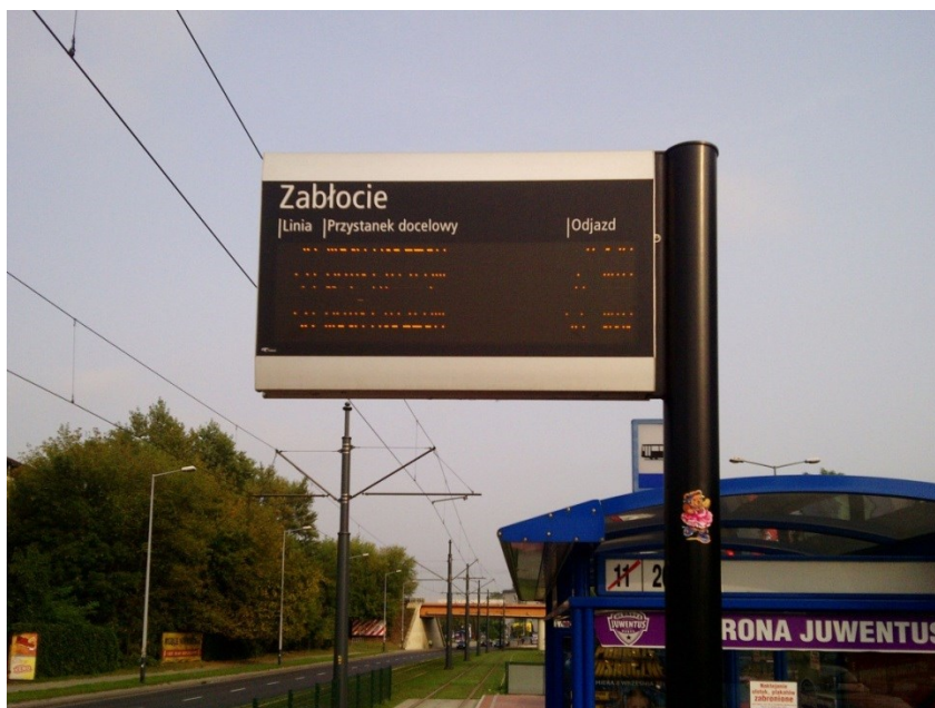
Rysunek 1. Przykładowa tablica LED zainstalowana na przystanku (uchwycono moment odświeżania tablicy)
